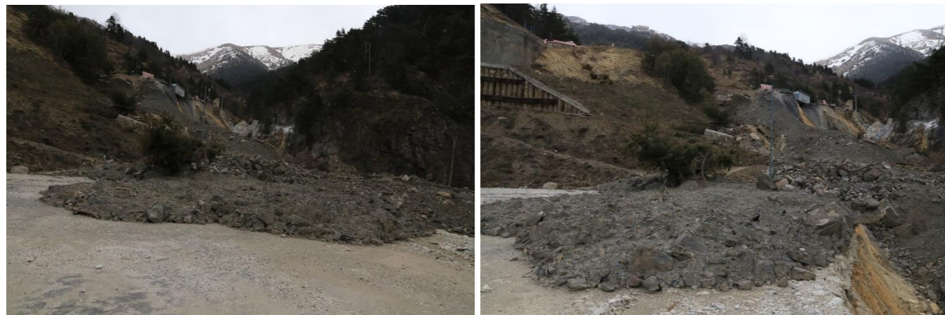
Illustration 45 "Lingua" di materiali alla fine della lava torrenziale. Queste figure di depositi alla fine del fenomeno sono caratteristiche dei detriti lavici.
