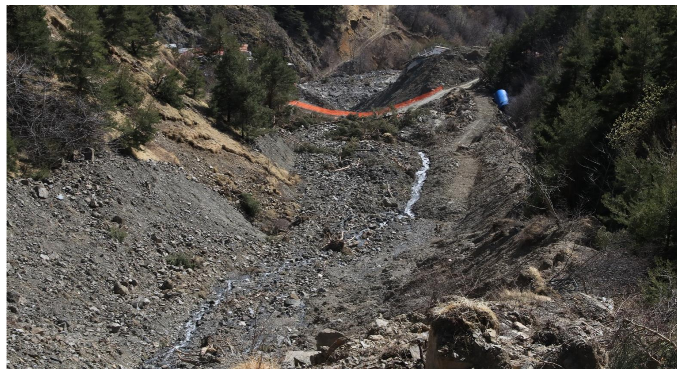
Illustration 39 Area di deposito a monte dei viadotti distrutti
