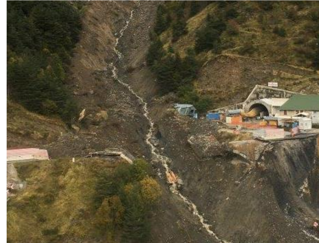
Illustration 85 Fotografia del sito dopo il crollo delle due strutture - 10/09/2020
