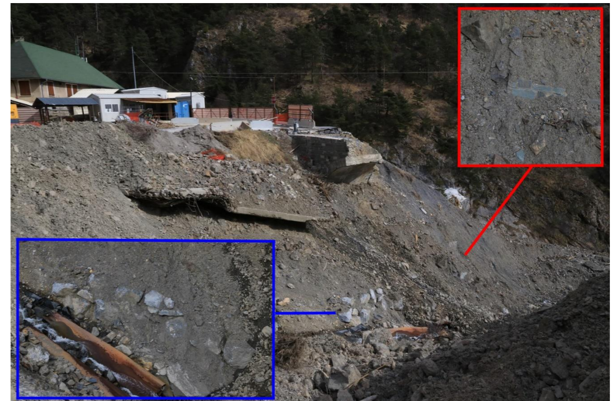
Illustration 43 Mura a valle dei viadotti
