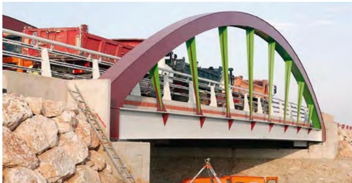
Illustration 93 Esempio di "corda d'arco" con arco autoancorato: Ponte di Roboul presso Perpignano (Francia)
