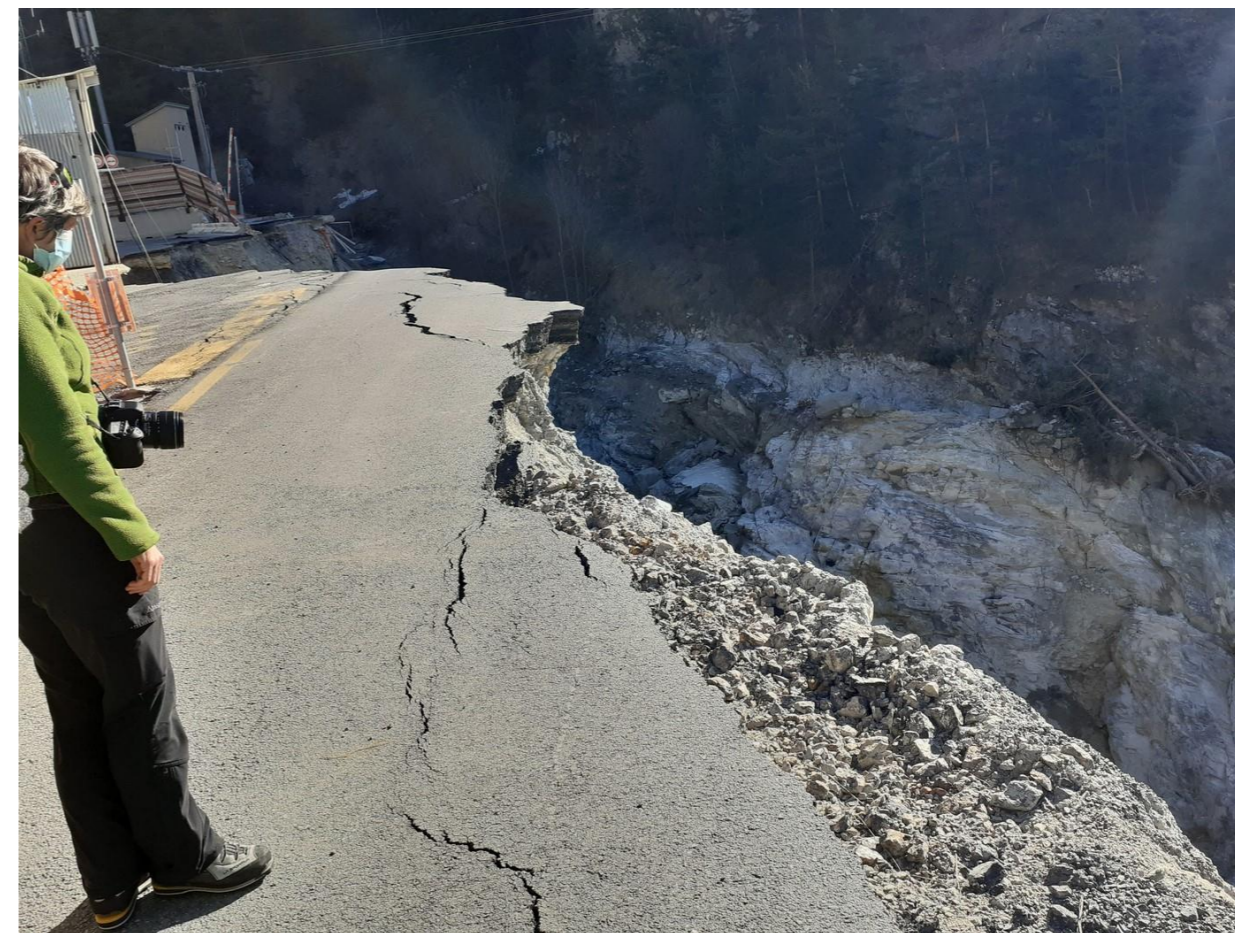
Illustration 126 Piattaforma di accesso alla canna Est - Vista in direzione della canna Est La piattaforma è "sospesa" nel vuoto.
