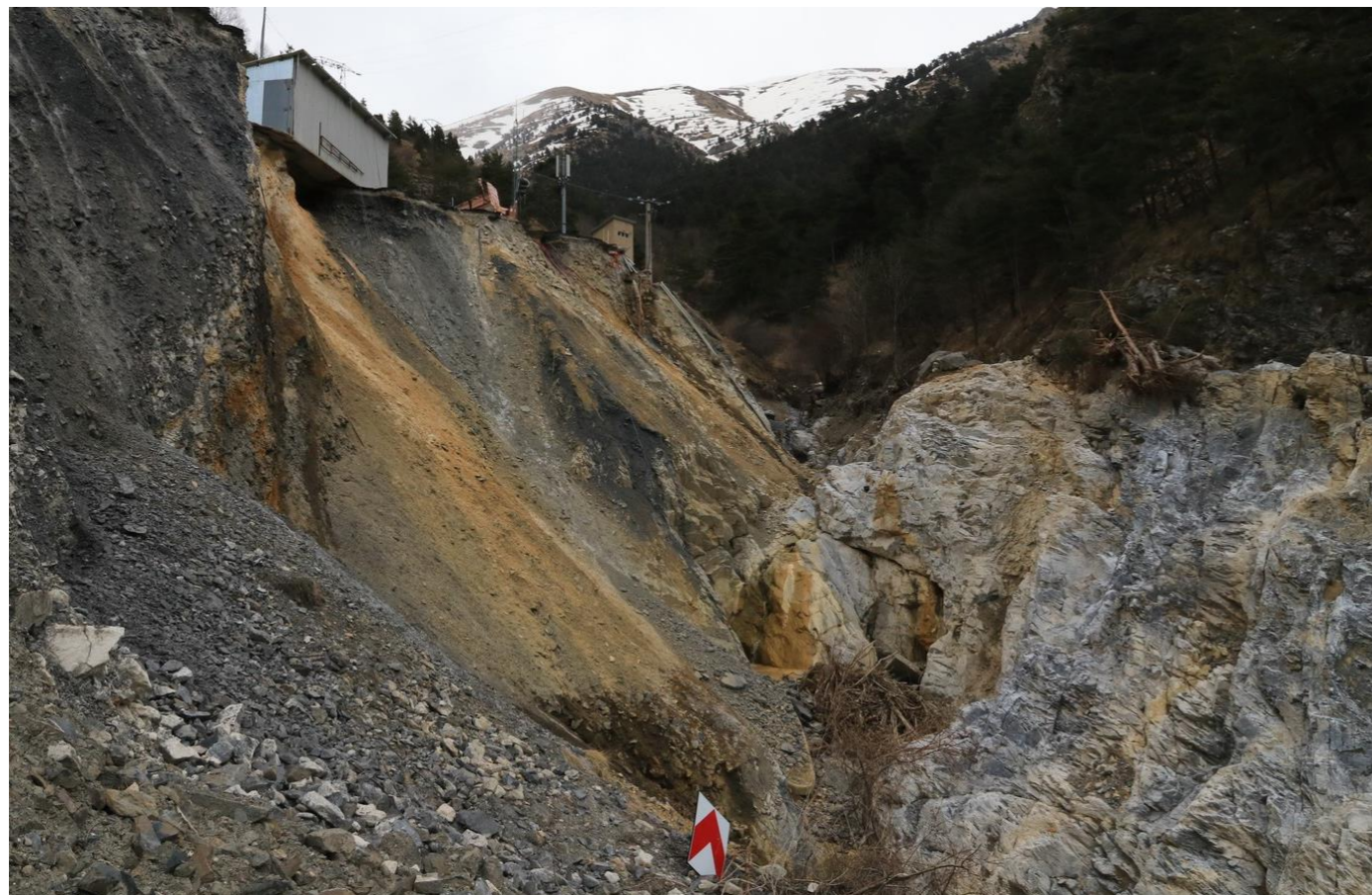
Illustration 131 Vista panoramica dei materiali presenti a livello del terrapieno sotto la piattaforma
