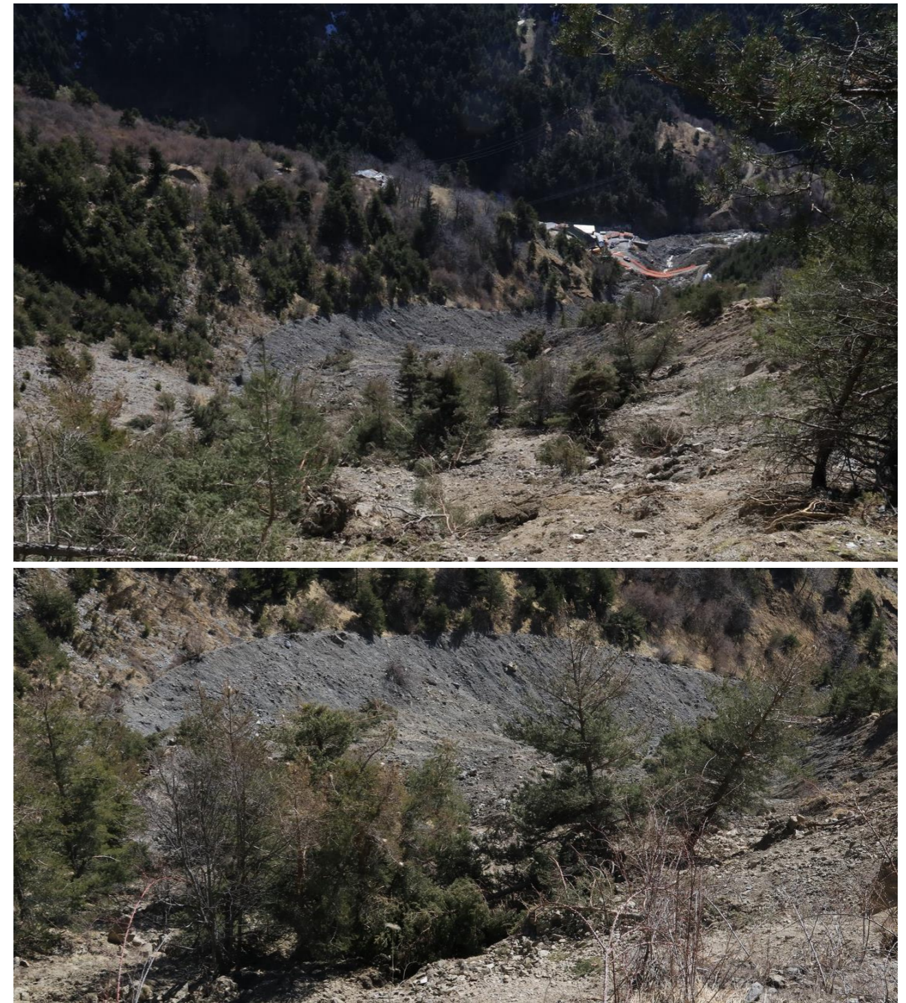
Illustration 36 Vista panoramica e dettaglio della "virgola"
