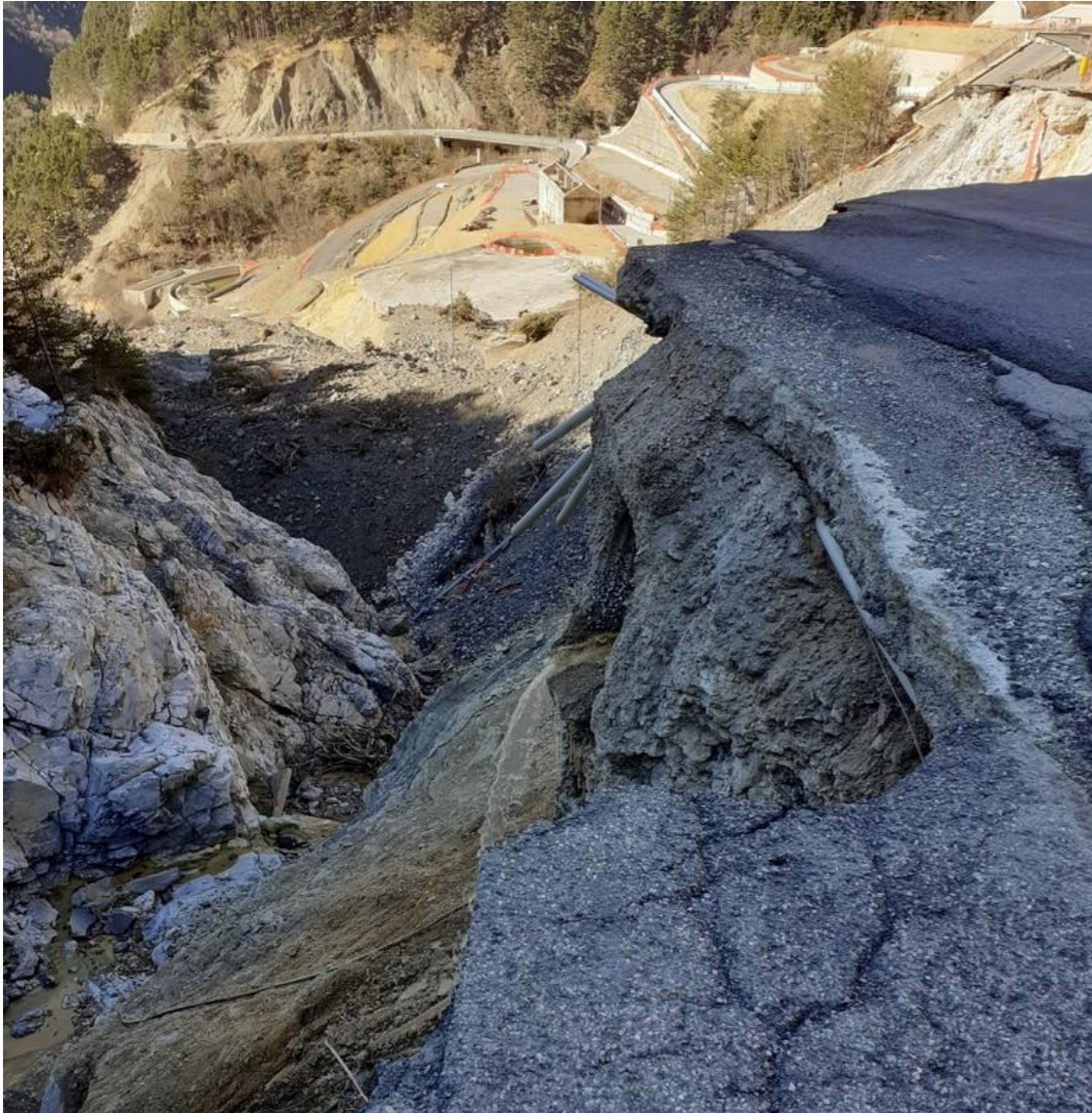
Illustration 128 Piattaforma di accesso alla canna Est - Vista in direzione di Tenda La carreggiata si basa su terreni più o meno induriti
