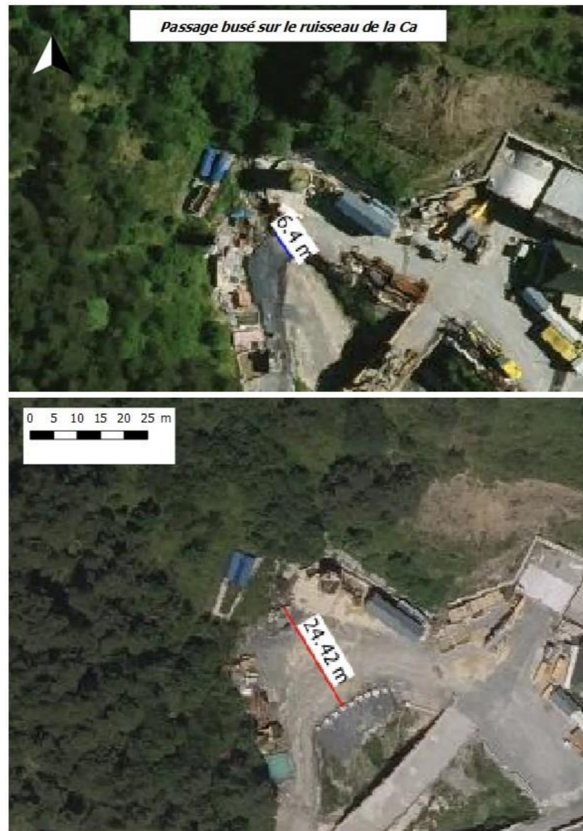
Illustration 28 Passaggio intubato sul ruscello Ca nel 2017 e 2020 (IGN©) Il "piccolo" passaggio intubato è diventato un'importante piattaforma di movimentazione.
