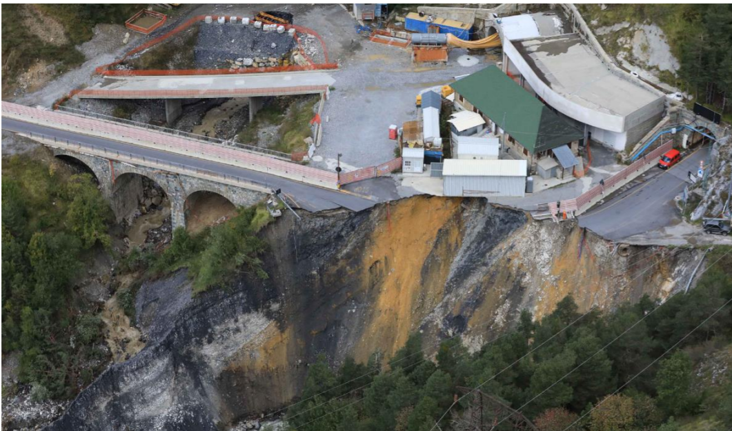
Illustration 84 Fotografia del sito dopo il crollo della piattaforma ma prima del crollo delle due strutture — 03/10/2020
