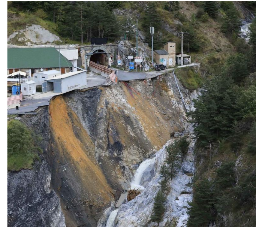
Illustration 4 : Piattaforma di accesso al tunnel storico (fotografia del 03/10/2020) Queste illustrazioni testimoniano la forte incisione del Roia nel suo letto (substrato calcareo osservabile nell'affioramento) che ha provocato la destabilizzazione del terrapieno a valle della piattaforma di accesso al tunnel storico.
